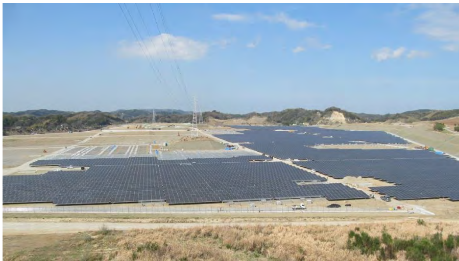
参考：建設中の富津太陽光発電所（発電容量：42MW）
