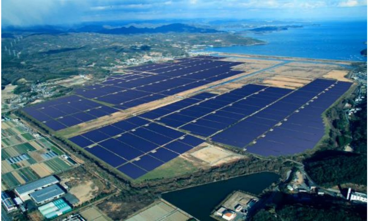
キャプション: 「瀬戸内 Kirei 太陽光発電所」の外観 (完成予想図) - 岡山県瀬戸内市に建設されている日本最大規模の太陽光発電プロジェクトで出力は 231MW にのびります。
