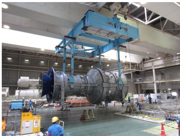
写真 1 : 横浜火力 7 号系列 ガスタービン交換の様子
