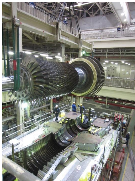
写真 2 : 横浜火力 7 号系列 ローター吊り上げの様子
