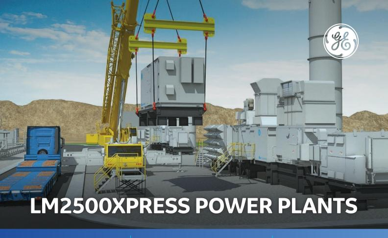
34 MW SIMPLE CYCLE OUTPUT
