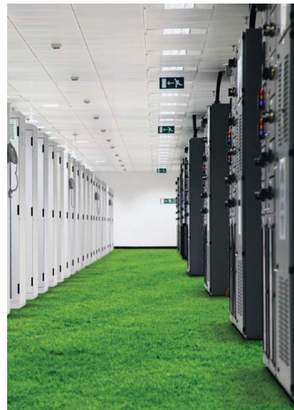
GEのエネルギー効率監視システム
